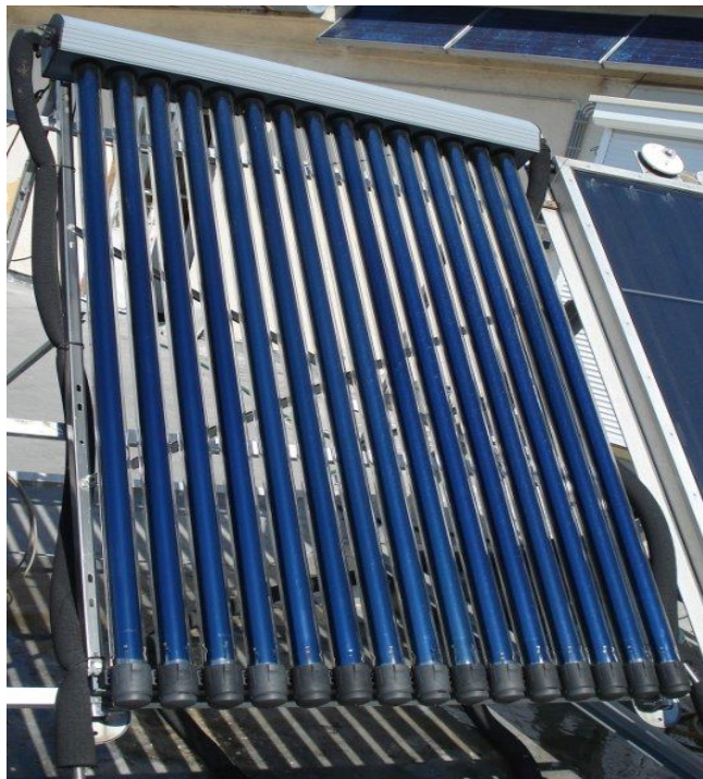
vákuumcsöves kollektor hasznos felülete 1,485 \text{ m}^2 (15csöves kollektor)
