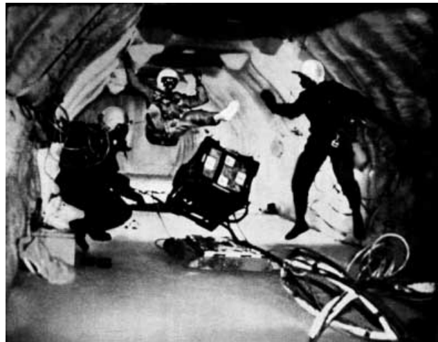
3. ábra. Az űrhajósok tesztelik a tüzelőanyag-cellát a súlytalanság körülményei között [18].
